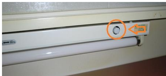
点灯管装着例 (丸内が点灯管)
